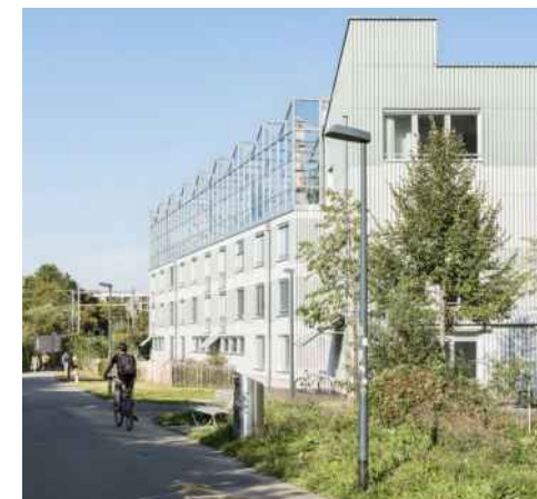
Wohnbebauung an der Parkverbindung (Bild Westhof Dübendorf, Roman Keller)
