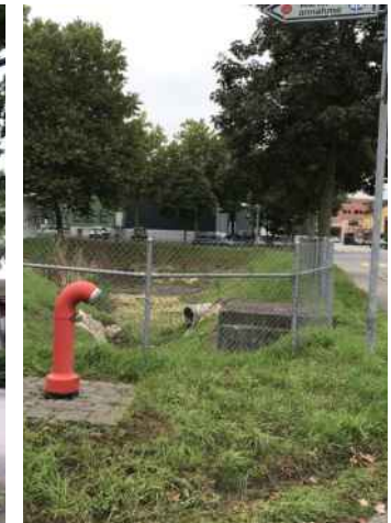
Retentionsbecken (Zaun als Sicherheitsmassnahme).
