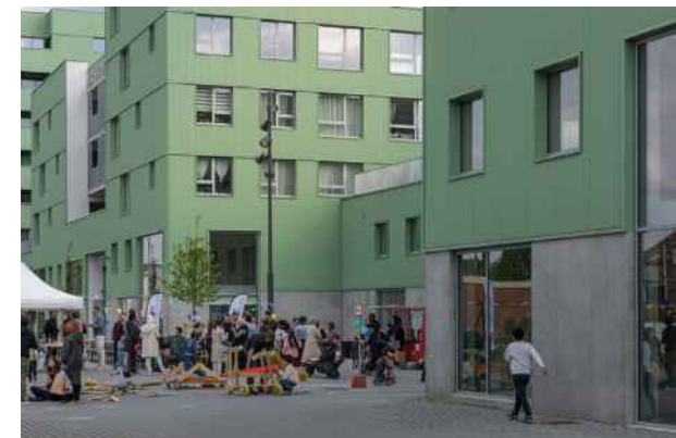
Beispiel Stapelung von Wohnen und urbaner Produktion (Quelle: Nova-City, Brüssel, bogdan design)
