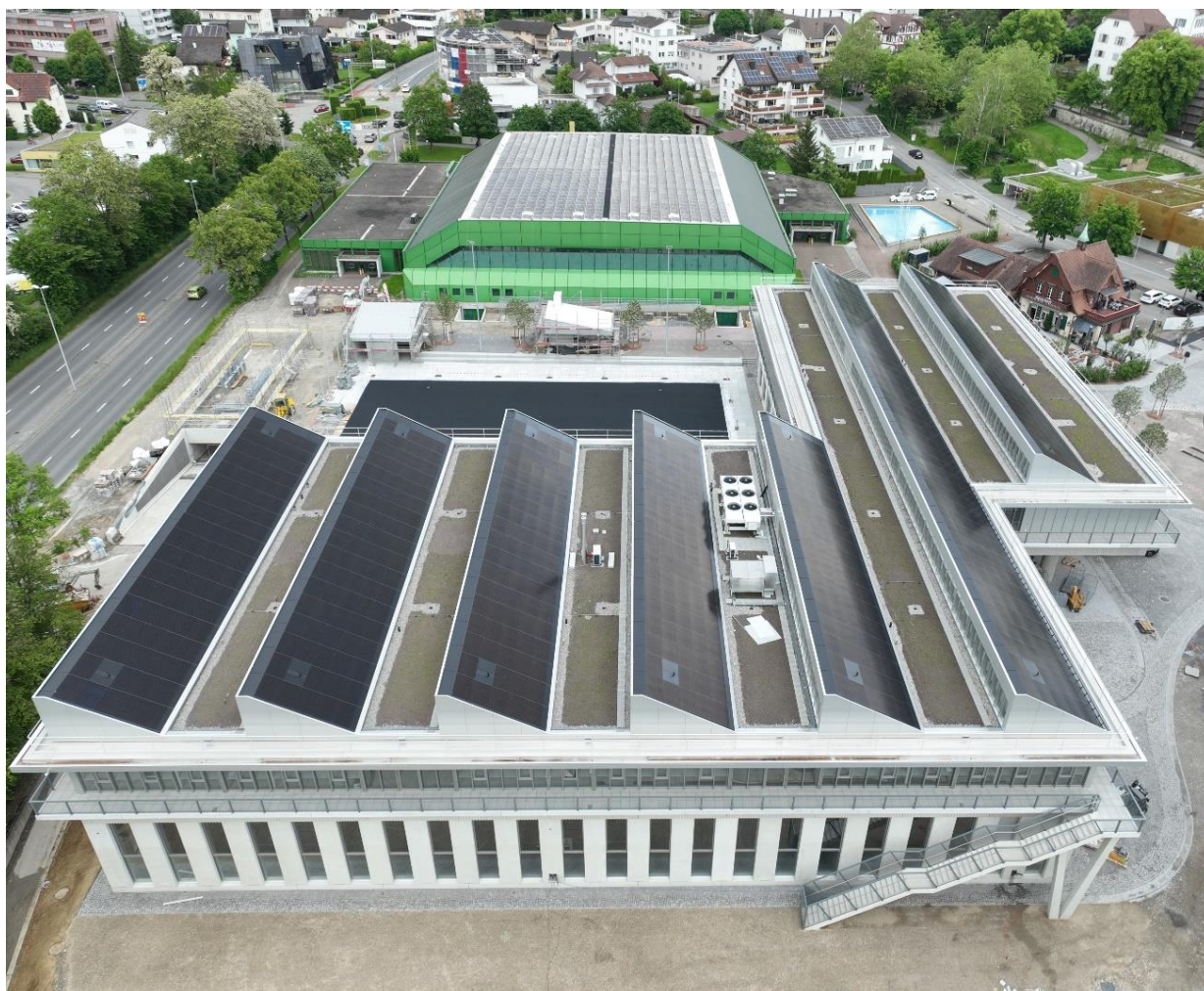
Dächer mit Solaranlagen auf Sekundarschulhaus Zirkusplatz und auf Stadthalle Sursee
