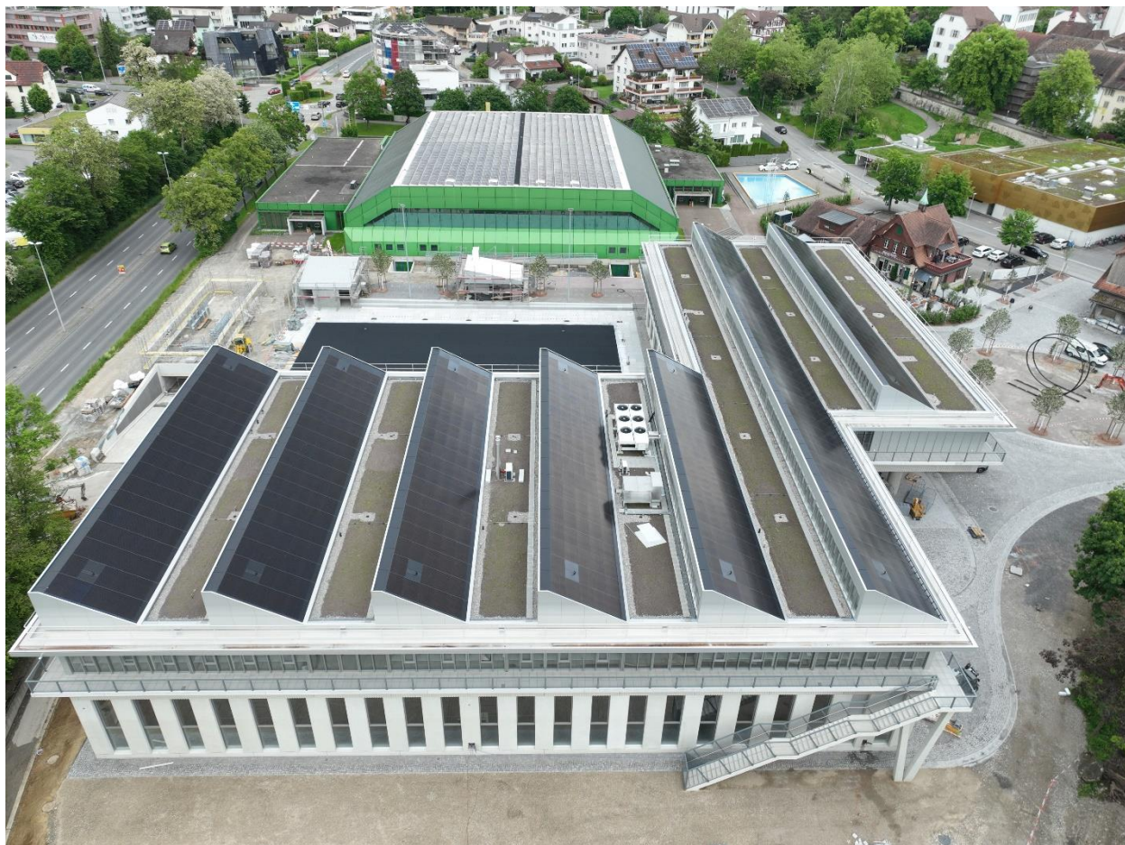
Dächer mit Solaranlagen auf Sekundarschulhaus Zirkusplatz und auf Stadthalle Sursee
