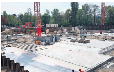
Die Baumeisterarbeiten beim Sekundarschulhaus Zirkusplatz werden ausgeführt.
