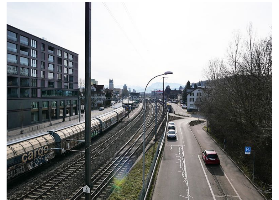
Foto 2020: PP+Gehweg Pilatusstrasse bestehend
