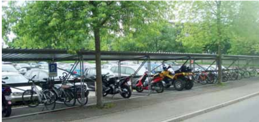
Abb. 15 Veloabstellanlage in der Leopoldstrasse
