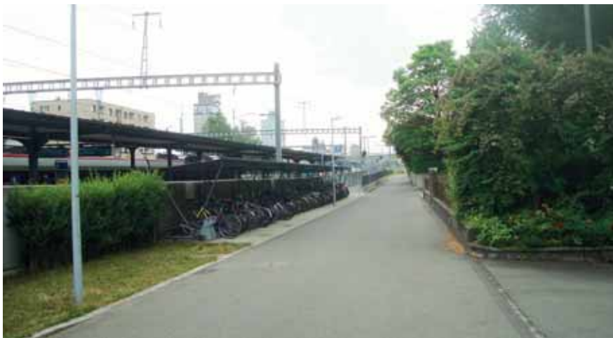
Abb. 16 Veloabstellanlage in der Pilatusstrasse
