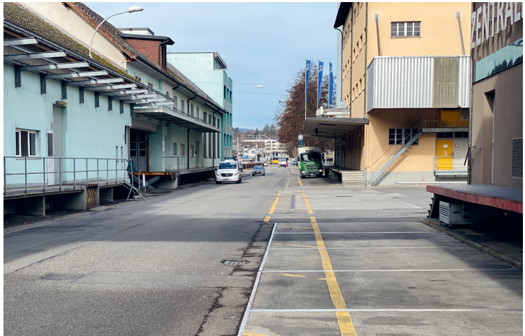
Die Fussgängerführung an der Merkurstrasse weist starke Defizite auf.
